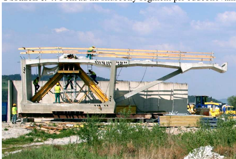
Obrázok č. 4: Pohľad na skúšobný segment pri oddebňovaní vzpier.
